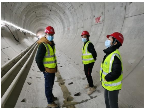
图1 西安地铁16号线施工现场
